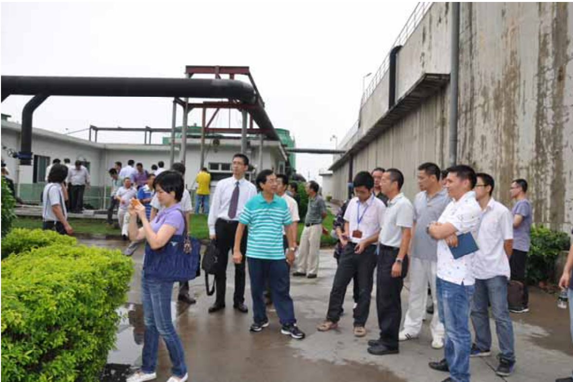
到达国泰公司污水处理厂现场
