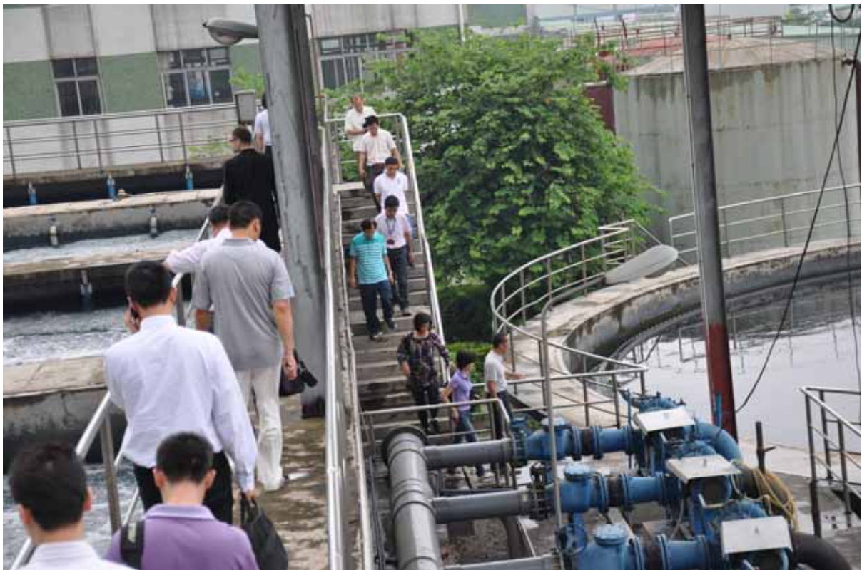
从耗氧池到生化沉淀池
