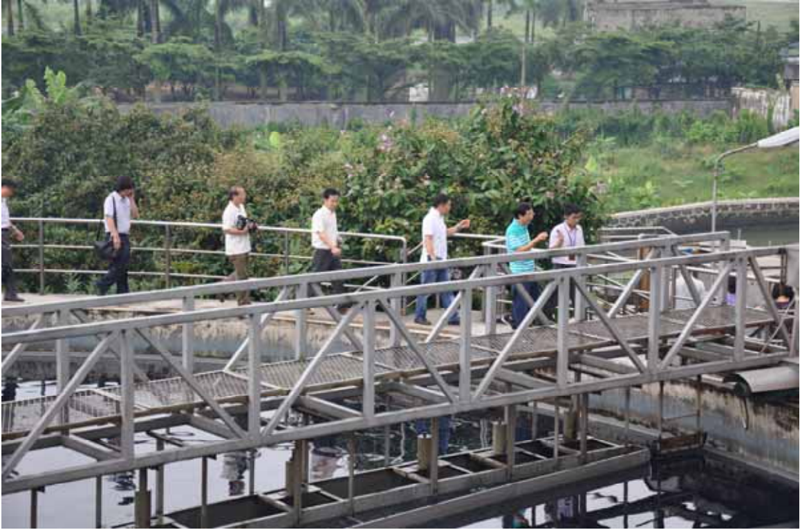
生化沉淀池现场
