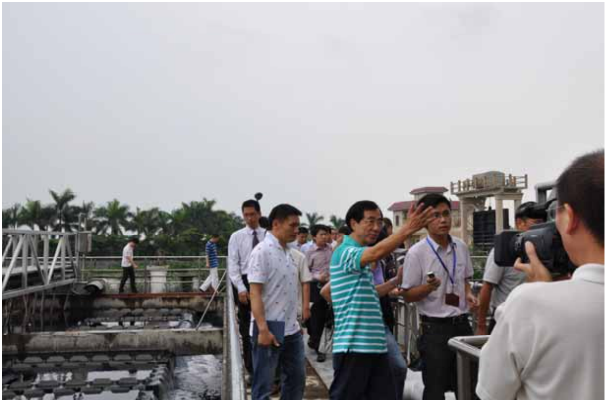
物化沉淀池现场
